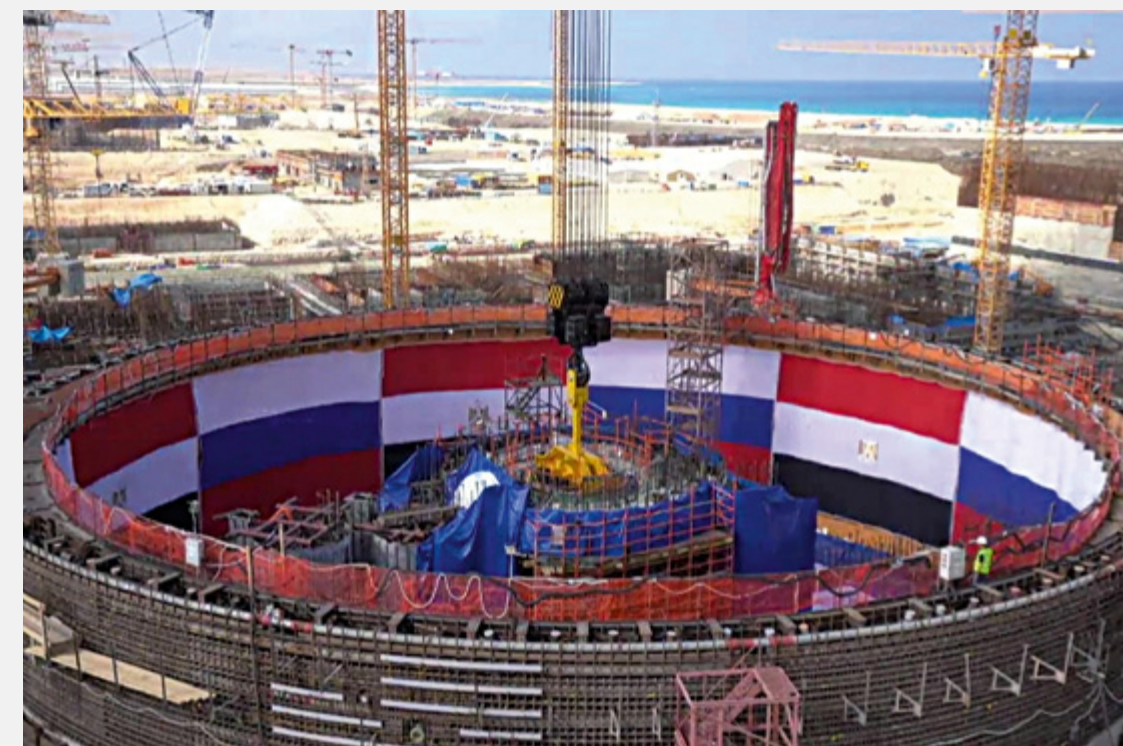
Установка корпуса реактора первого энергоблока египетской АЭС «Эль-Дабаа». 19 ноября 2025 года
